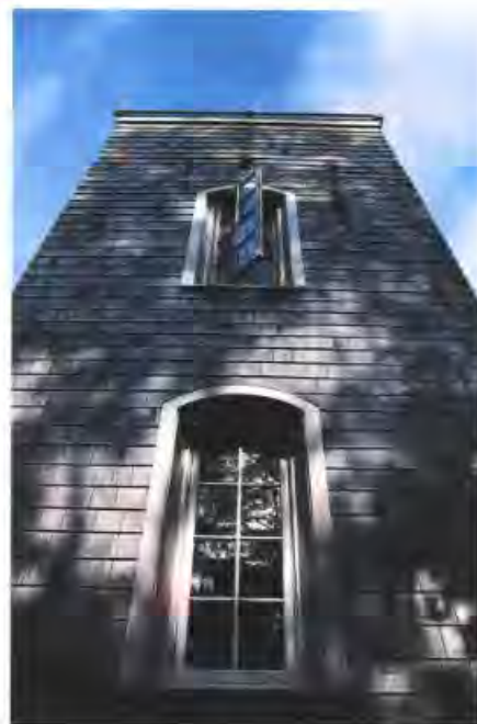
La tour de la villa, dédiée à un escalier intérieur en verre et acier brossé surplombé par un toit transparent.
